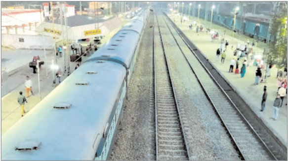
जंक्शन के मध्य अंडरपासों का निर्माण पूर्ण हो चुका है। 26
