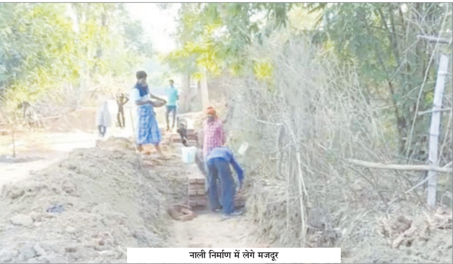
नाली निर्माण में लेगे मजदूर
